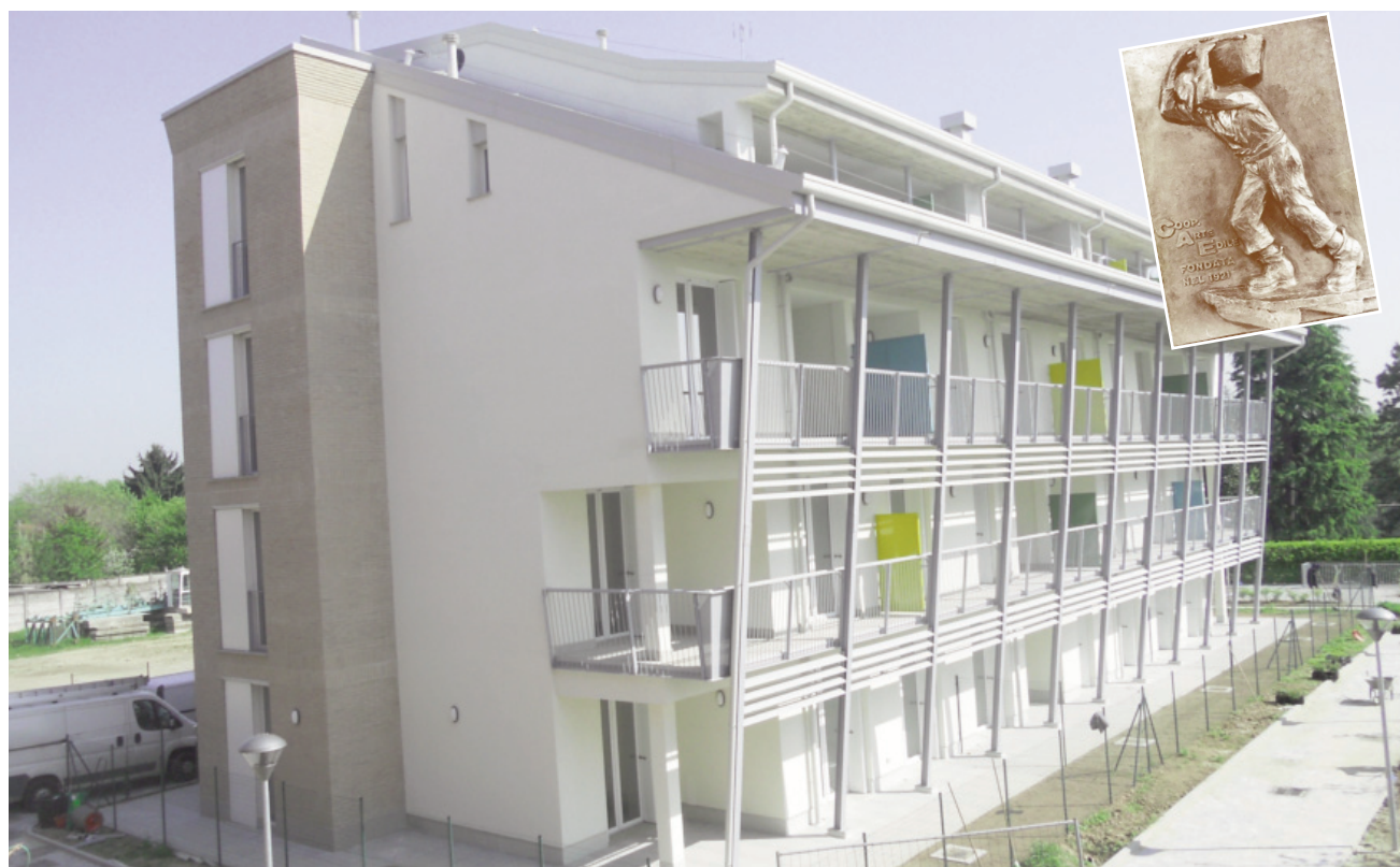
QUARTIERI NEL CAPOLUOGO - Qui un complesso a Milano Affori; sopra, una nuova costruzione a Milano Silla; in basso, la costruzione dell'acquedotto di Abbiategrasso, tutti opera della Cooperativa Arte Edile
